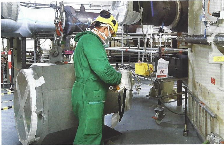
Ausbau eines Frischdampf-Isolationsventils, KKI 1.
