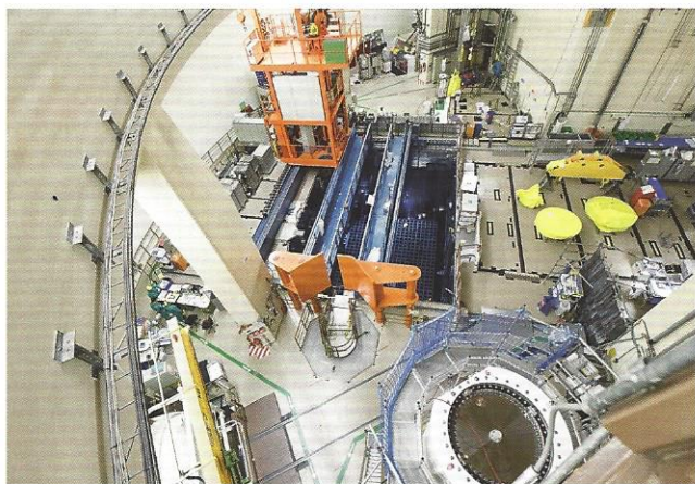
Blick auf CASTOR®-Abfertigung und Brennelementlagerbecken, KKG Grafenrheinfeld.
